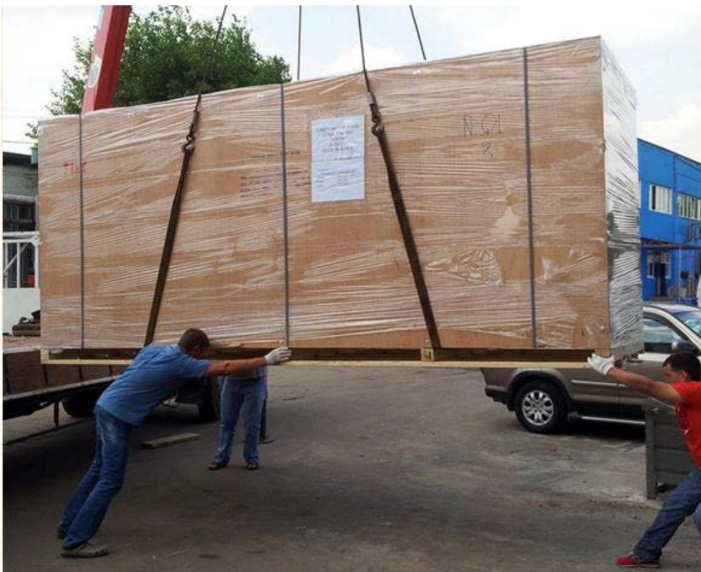
**Рисунок 6.3 — Строповка моношкафа АТ27-М20...М32 в наружной упаковке**
